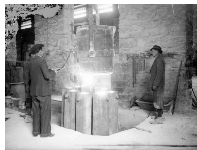
Siviera: recipiente per il trasporto della colata negli stampi (foto Magnolini)
