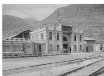
Palazzina Uffici ed entrata della SELVA (foto Magnolini)
