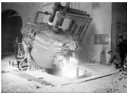
Primo forno ad arco (foto Magnolini)
