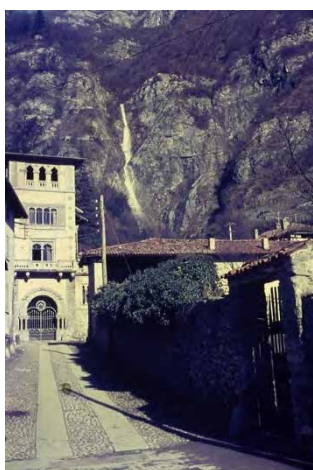
Torre d'entrata (portineria) alla proprietà Gheza; anni '50-'60
