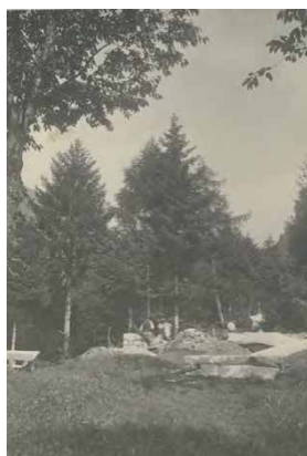
Inizio lavori casa di Piazza
