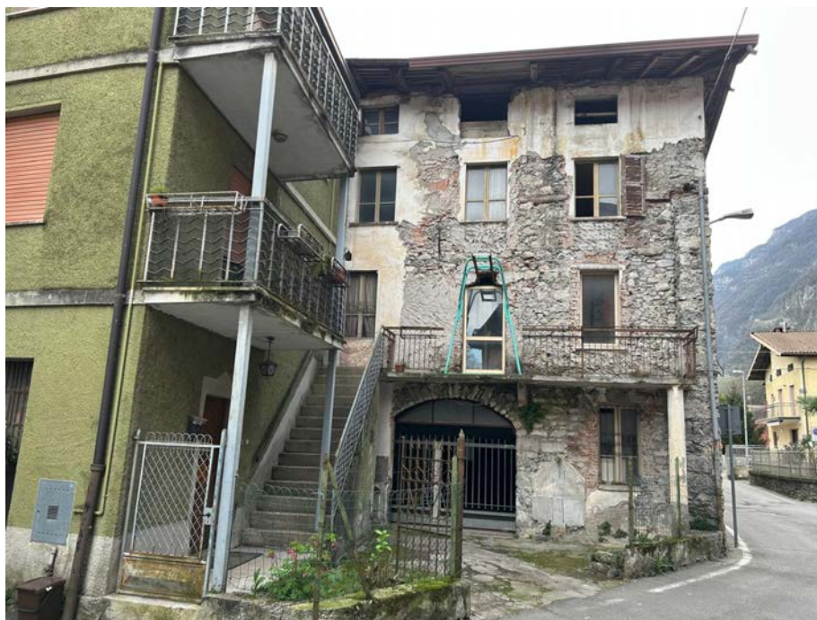
Fig. 68. Casa del mezzadro in Piazzola
