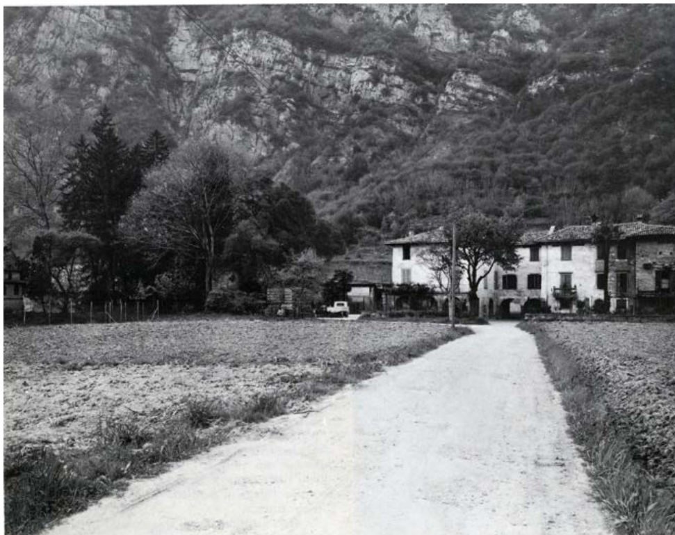
Fig. 41. Viale di accesso all'edificio negli anni Sessanta
