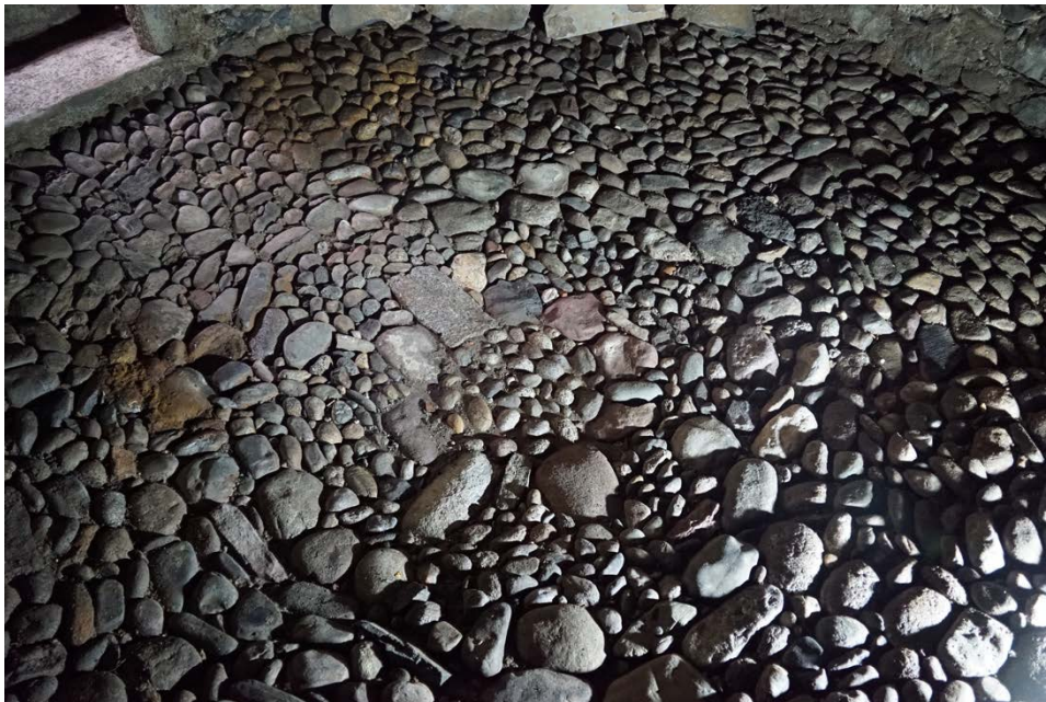
Fig. 24. Pavimento concavo in acciottolato ( balòte de rih )
